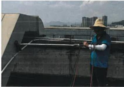
VI 实验废气排气筒处理前采样口
