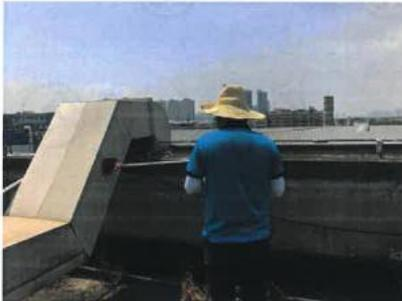
III 实验废气排气筒处理前采样口
