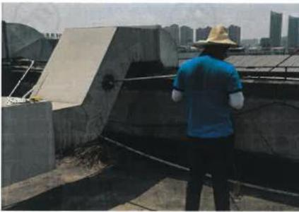
IV 实验废气排气筒处理前采样口
