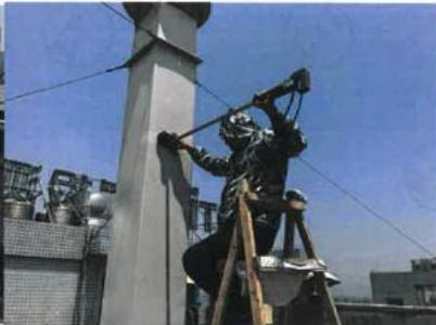
IV 实验废气排气筒处理后采样口
