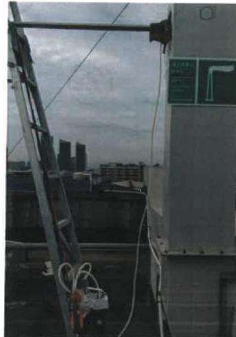
II 实验废气排气筒处理后采样口
