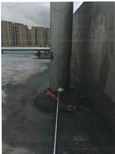
二期加弹项目排气筒出口 20#
