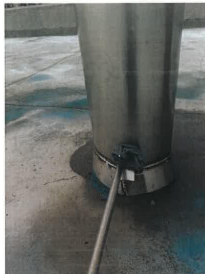
一期加弹项目排气筒出口 13#
