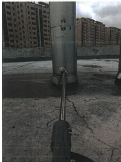
一期加弹项目排气筒出口 17#
