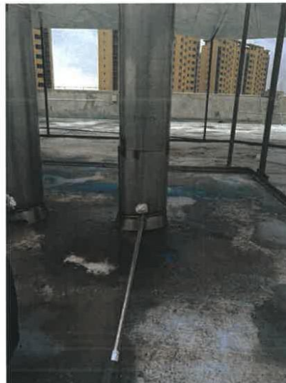
二期加弹项目排气筒出口 25#
