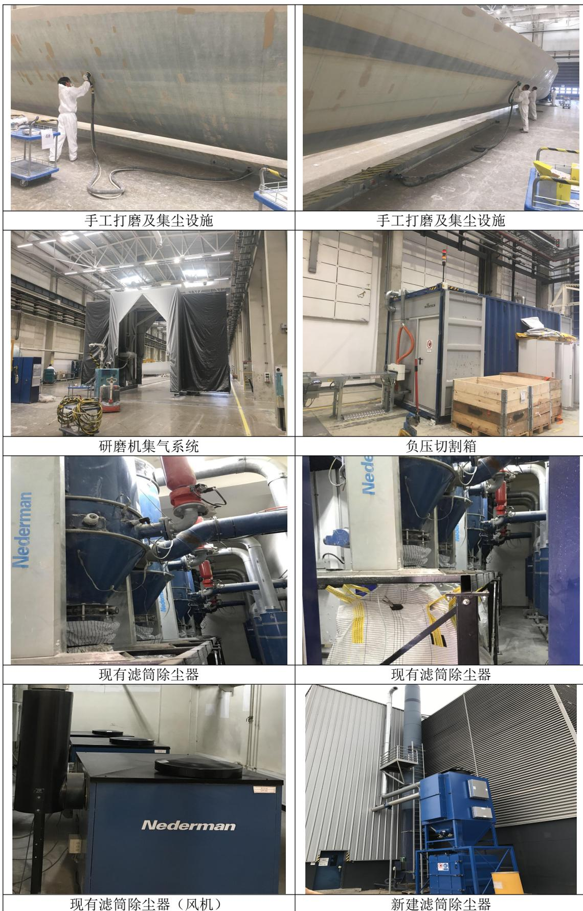
图 4.1-2 产尘工序及滤筒除尘器实景图
