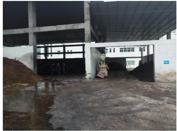
药渣、煤渣仓库
