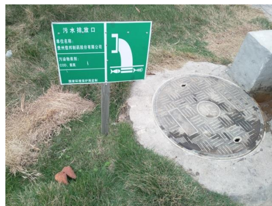
污水总排放口
