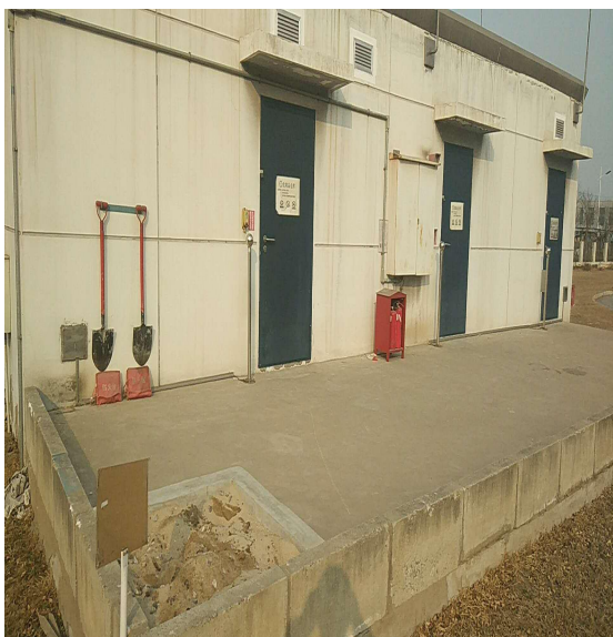
图 3：化学品库门口的干粉灭火器及砂箱
