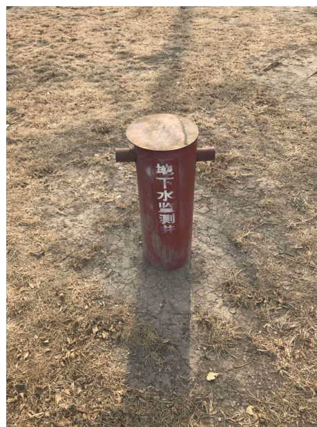
图 8 厂区内地下水监测井
