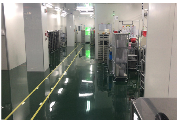
图 5：车间地面防渗措施
