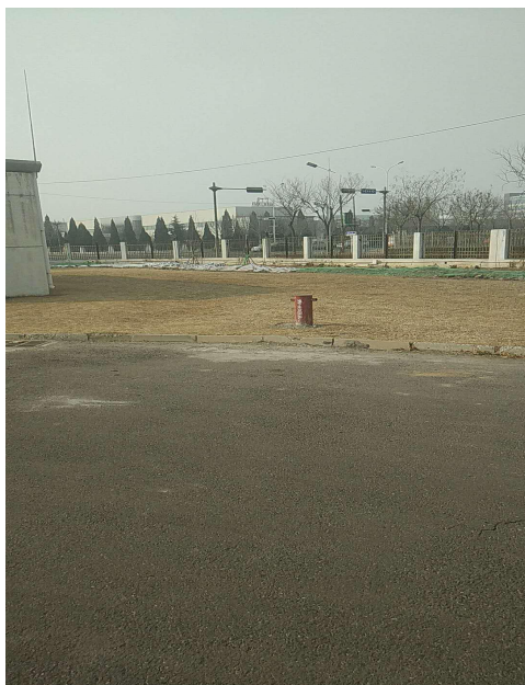
图 7 厂区内地下水监测井
