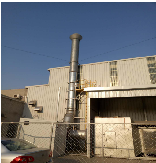
图 2 废气排气筒 P9
