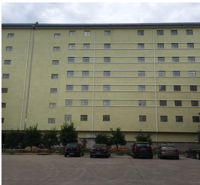
厂区西面外图
