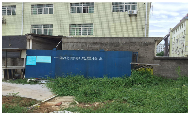
图 8.7-1 A/O 法一体化污水处理设备
