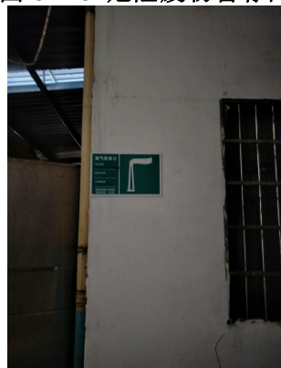
图 8.7-6 车间 1-3#废气排放口标识
