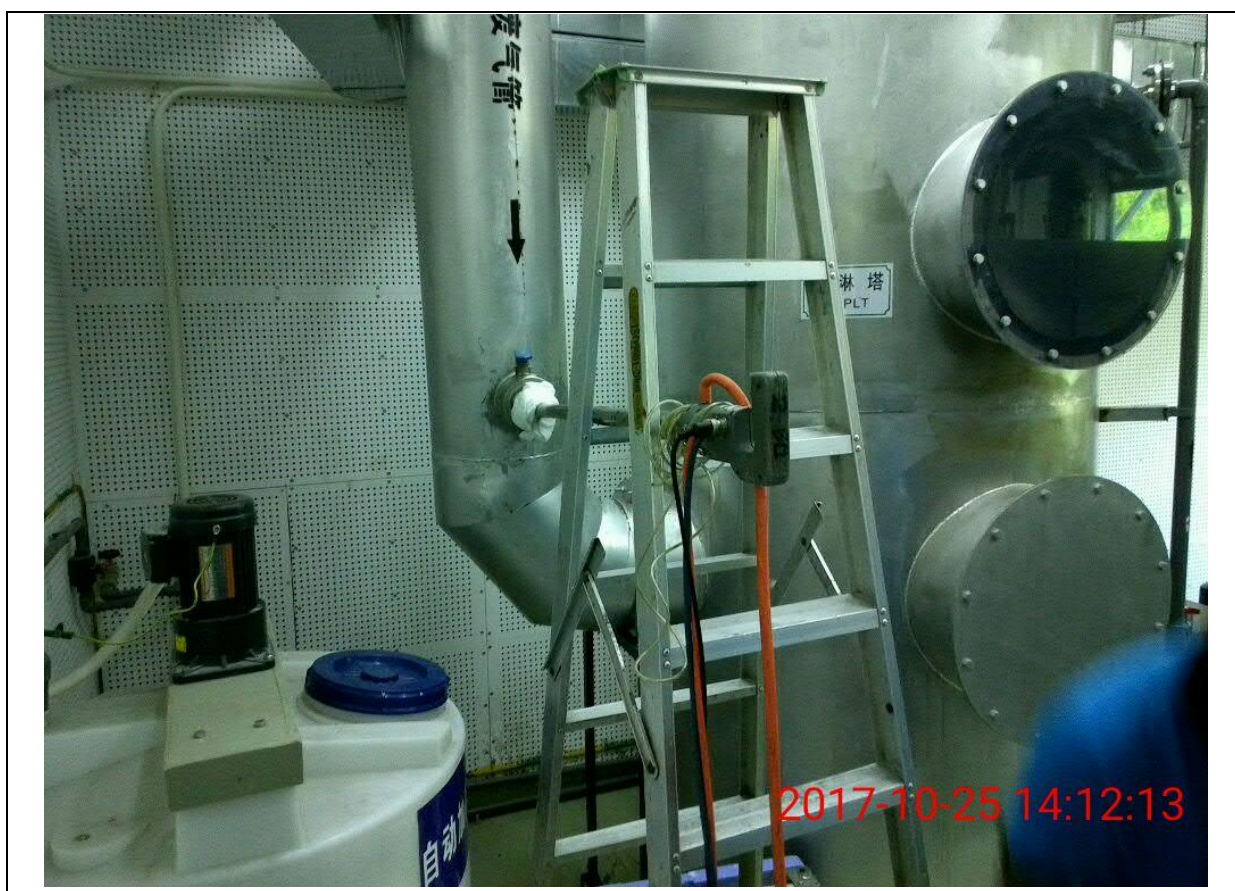
图 15 粉尘废气处理设施
