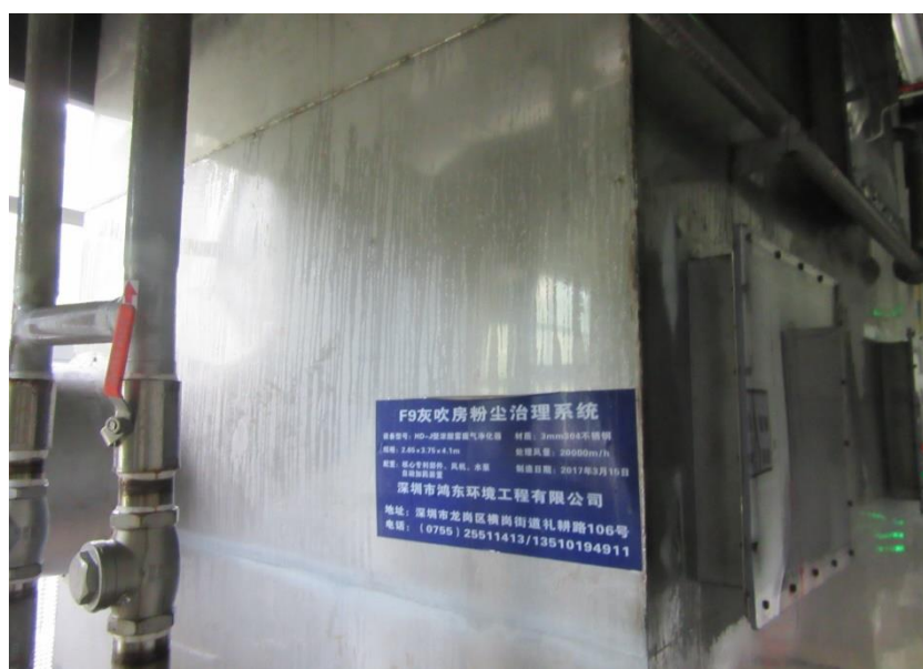
图 17 含铅废气处理设施
