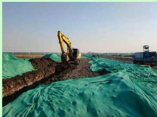
对施工物料和裸露地面进行苫盖
