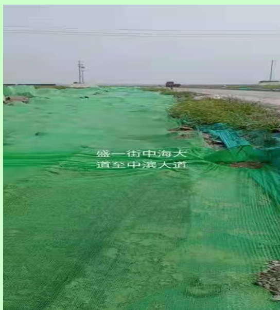
图 4-4 管沟回填、苫盖照片
