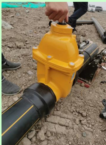
图 4-7 燃气管道应急截断阀门
