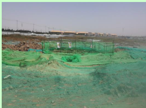
对施工物料和裸露地面进行苫盖
