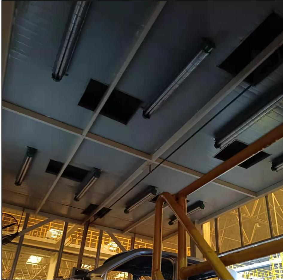
图 6 焊接间内顶部排风口
