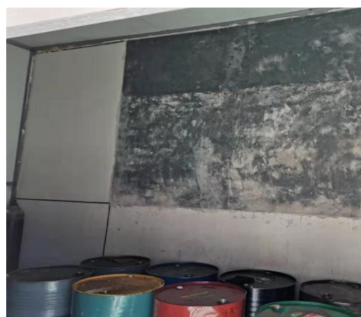
图 3-6 危废暂存间内部
