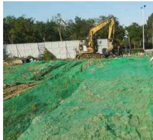
图 4-7 热力管道施工期施工围挡及苫盖措施(1)
