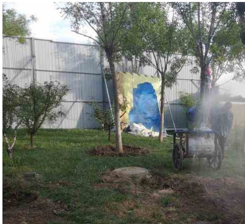
图 4-6 热力管道施工期雾炮抑尘措施
