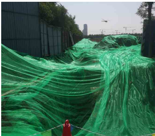
图 4-8 热力管道施工期施工围挡及苫盖措施(2)
