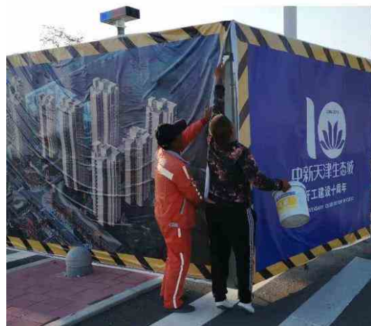
图 4-9 热力管道施工期施工围挡
