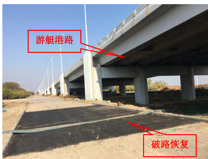
破路恢复情况（游艇港路）
