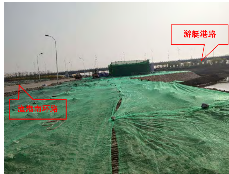
施工期苫盖措施
