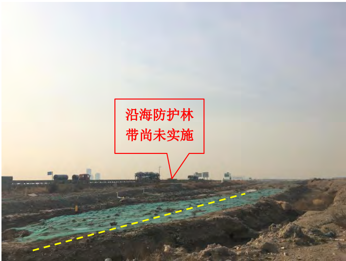
图 4-7 施工范围内涉及防护林带保护生态区域现状（拍摄日期：2019.11）
