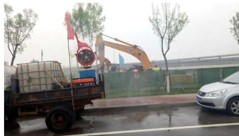
图 6-2 施工期洒水抑尘措施
