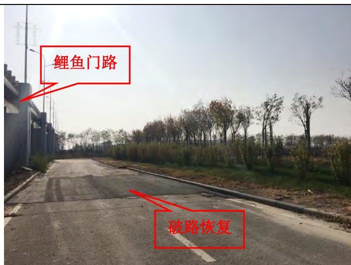
破路恢复情况（鲤鱼门路）
