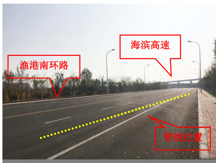
破路恢复情况（渔港南环路）
