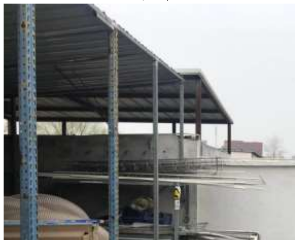
(设备维修) 工具暂存间
