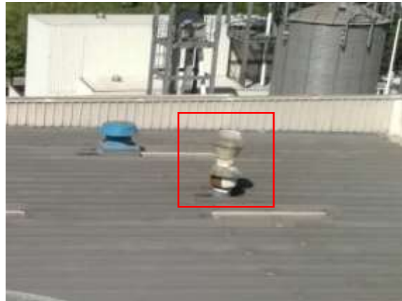
混合机废气逸散口 8
